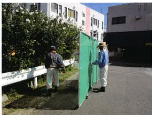
機械刈除草の作業中、防護ネットを使用し飛び石による事故を防止
